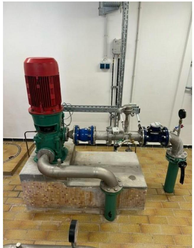
Ersetzt wurde die Pumpe gegen eine „Neue Pumpe“ mit der höchsten Energie- und Effizienzklasse. Durch den Einsatz neuester Technik erhoffen wir uns eine deutliche Reduzierung des Stromverbrauchs.
